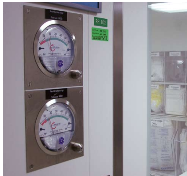
Schleusen Differenzdruck-Überwachung mittels Volumenstromregelung. Innen- und Aussendruck.
