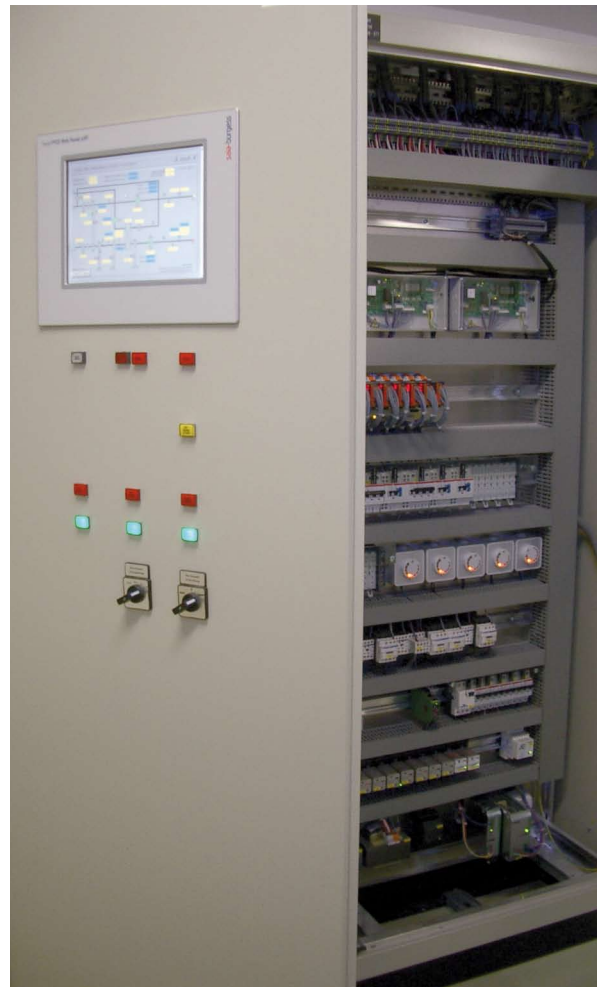
Vor Ort Touch-Screen. Bedienung und Überwachung dank Web-Server Technologie.
