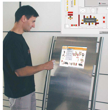
Bildschirmdarstellung am Eingang jedes Stockwerkes mit dem Touch Screen PC unter Saia®Visi.Plus. Nach Wahl der Bürozone erscheint das entsprechende Bedienfeld für Licht und Storen
