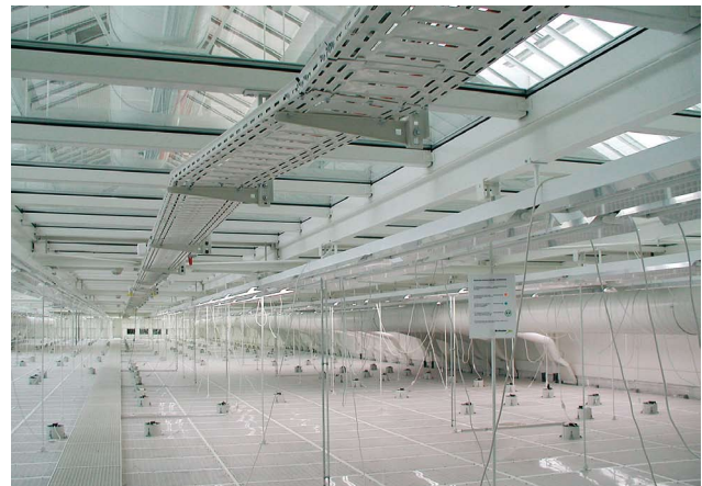
In der Lichtdecke über dem grossen Pfistersaal wird das Tageslicht über Lamellen und das Kunstlicht mittels Fluoreszenz- oder Spotlampen zonenspezifisch geregelt
