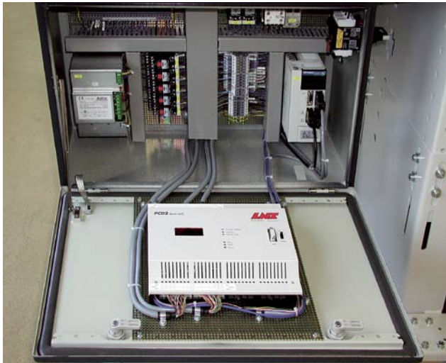
Steuerung des Stangenladers QUICK LOAD SERVO III. Dank der schmalen Bauweise findet die Saia®PCD2 Serie xx7 auch in der Tür Platz
