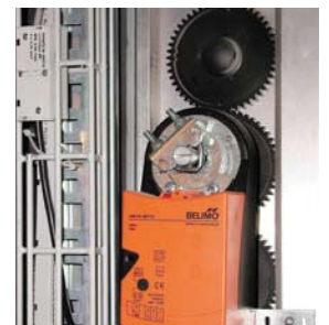
Klappenantrieb von Belimo® angeschlossen an den MP-Bus über Woertz-Anschlussklemme
