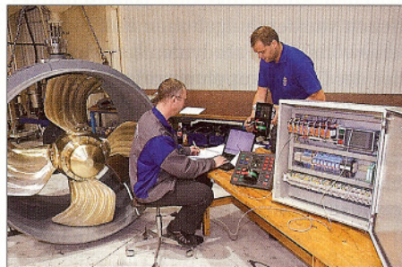
Schaltschrank mit SaiaPCD3 Steuerung: Vor der Auslieferung wird ein kompletter Test des Gesamtsystems durchgeführt
