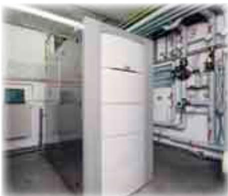
Immagine Vaillant GmbH Caldaia a celle di combustibile durante un test in campo, in condizioni di funzionamento reale
